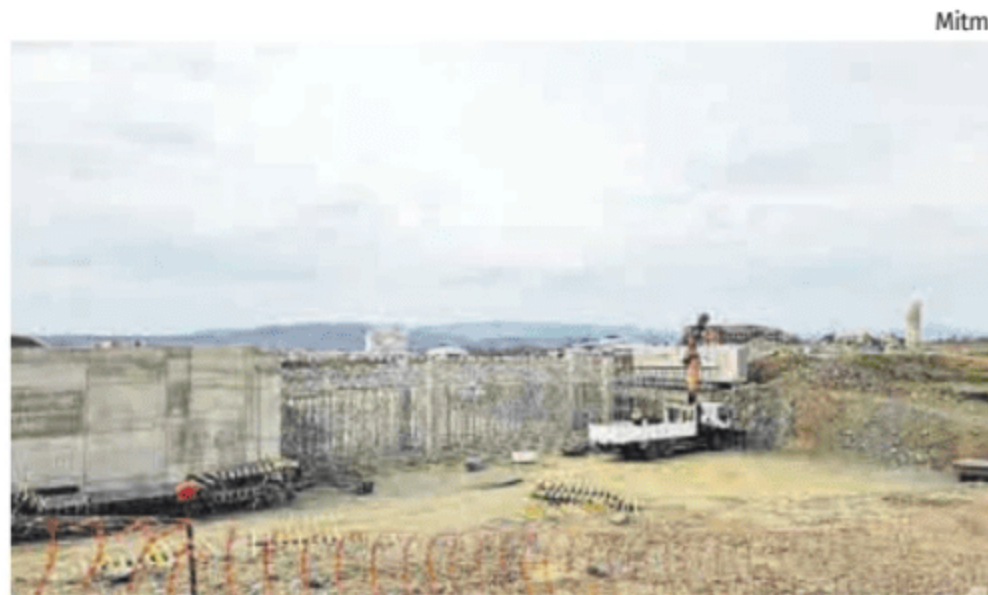
Las obras están al 60 % de su ejecución.
