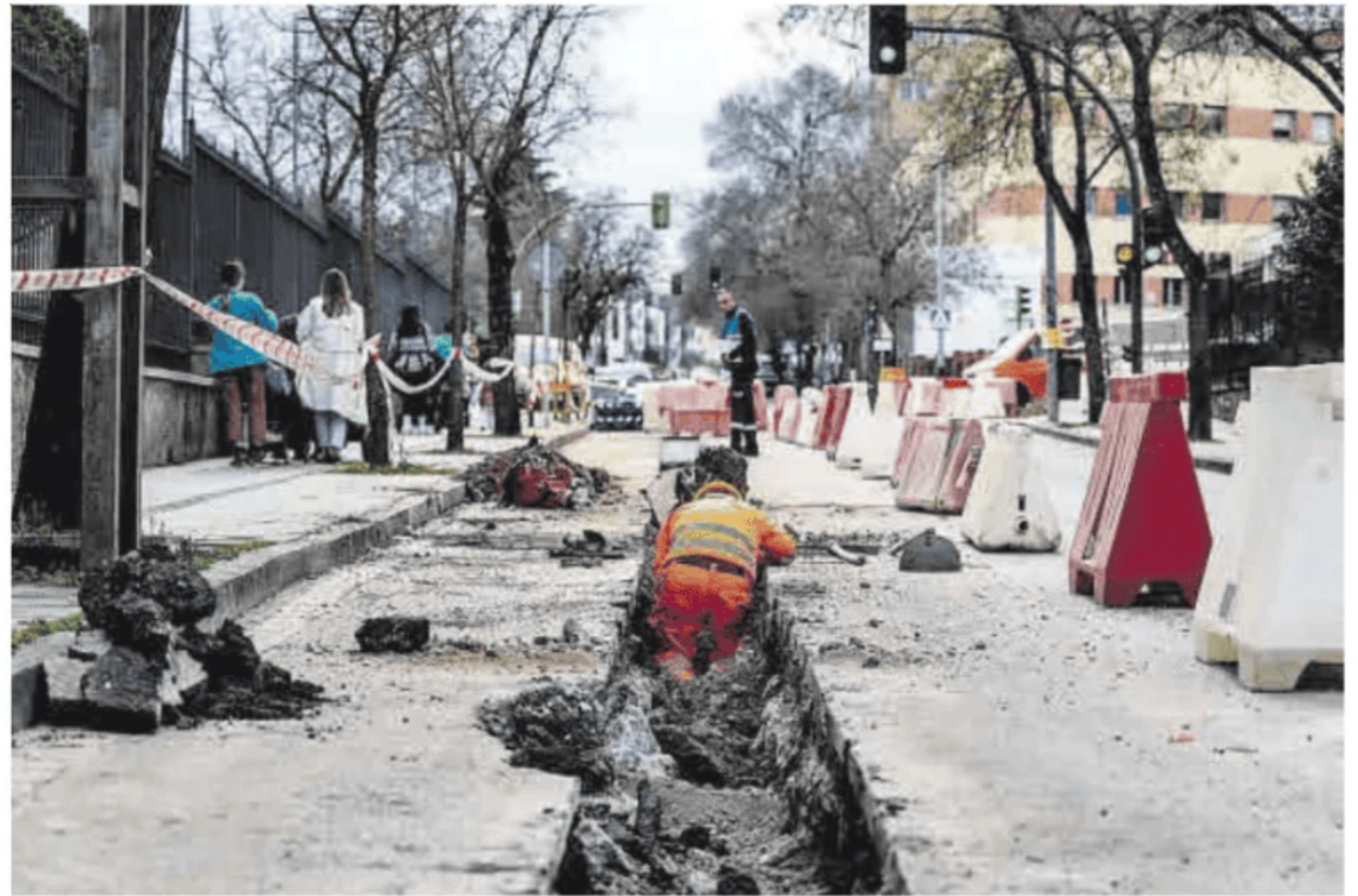
Un operario trabaja en las obras de la red de saneamiento.
